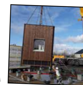
12 février : pose des 18 blocs préfabriqués
